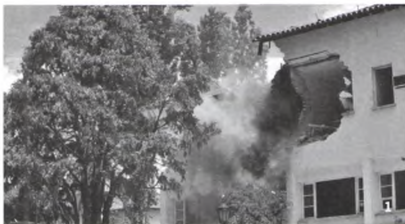
1 y 2, La Casa de las Tejas durante su demolición; imagen de la fachada antes de la intervención.
