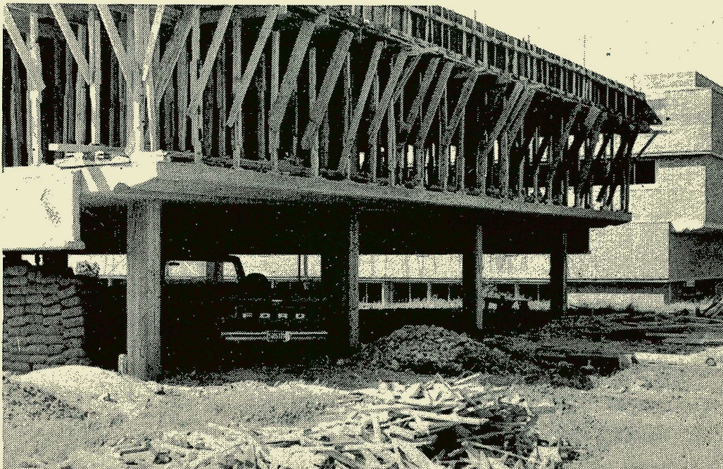
DEPENDENCIAS DE LA FACULTAD DE CIENCIAS AGROPECUARIAS EN CONSTRUCCION
