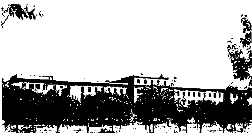
El Colegio Máximo. Fachada N. O.
