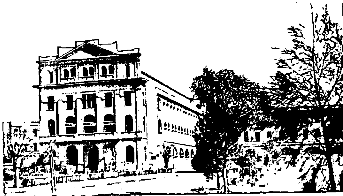
Antigua fachada del Colegio Máximo
