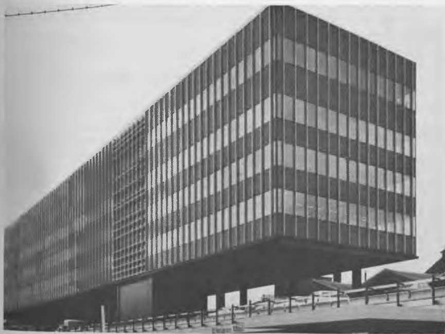
FIG. 8. — Bâtiment vitré en double vitrage avec couche semi-réfléchissante.
